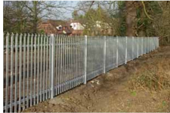
طبقة الخارصين الموجودة على هذا السور تحميه من الصدأ.
