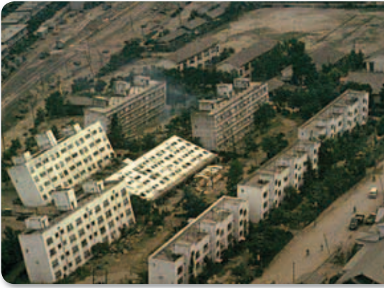
■ الشكل 18-3 يحدث تسييل التربة في التربة الضعيفة التماسك عندما تنتشر اهتزازات زلزالية فيها، فتسلك سلوك الرمال المتحركة.
