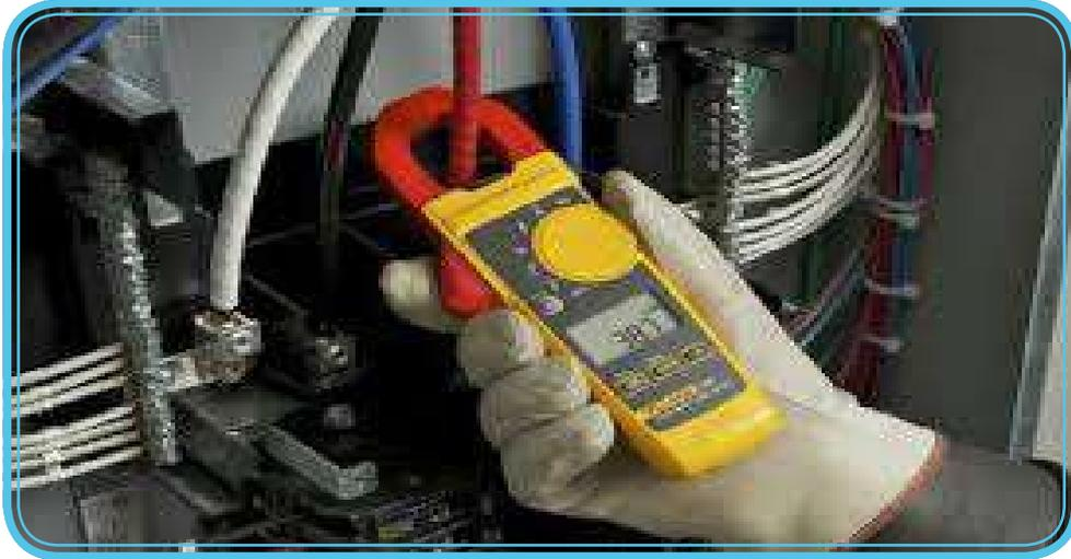
قياس التيار المسحوب من الضاغط.
