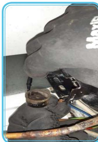
توصيل الأسلاك الكهربائية للأوفلود ومرحل التيار وتثبيته على جسم الضاغط.
