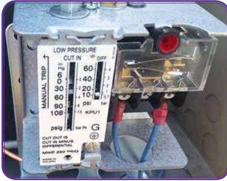
الشكل (7-18): قاطع الضغط المنخفض Low Pressure Switch.
