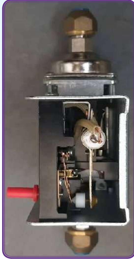
الشكل (7-23): المزدوج الحراري بين نقاط التلامس الداخلية لقاطع ضغط الزيت.
