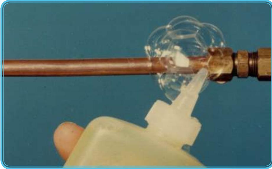
الشكل (5-13): كشف تسرب وسيط التبريد بالرغوة.
