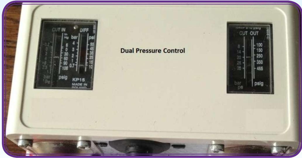
الشكل (7-21): قاطع الضغط المزدوج (HP/LP) Dual Pressure Control.
