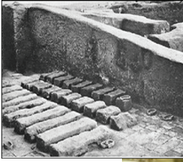
الشكل (١٢): البناء المكتشف في مدينة ماري.
