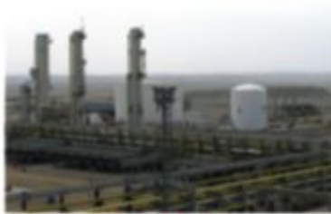
محطة تنقية مياه شكل (٢٠)
