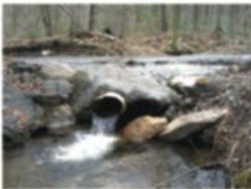
إلقاء مياه الصرف الصحي في الترع شكل (١٨)
