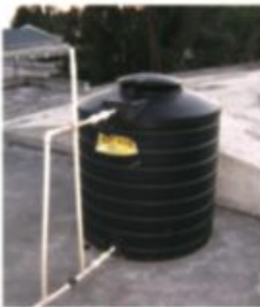
خزان مياه شكل (٢١)
