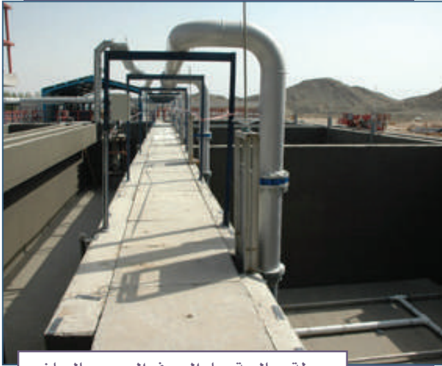
محطة معالجة مياه الصرف الصحي بالرياض
