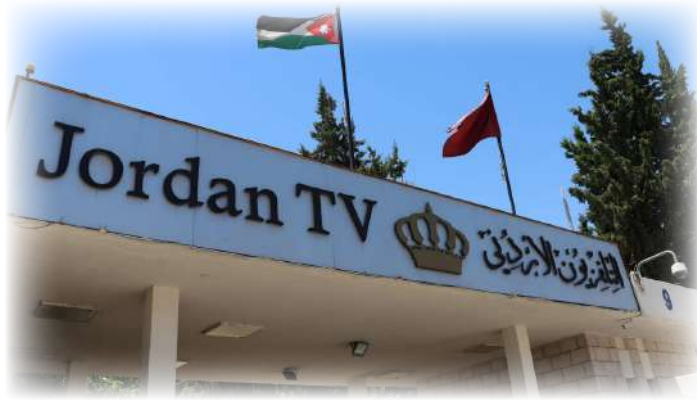
الصورة (16): مبنى التلفزيون الأردني.
